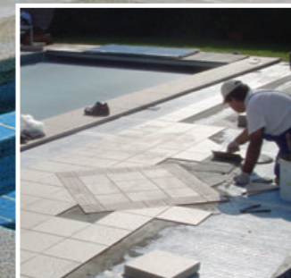
Pokládka dlažby na rohož Watec
